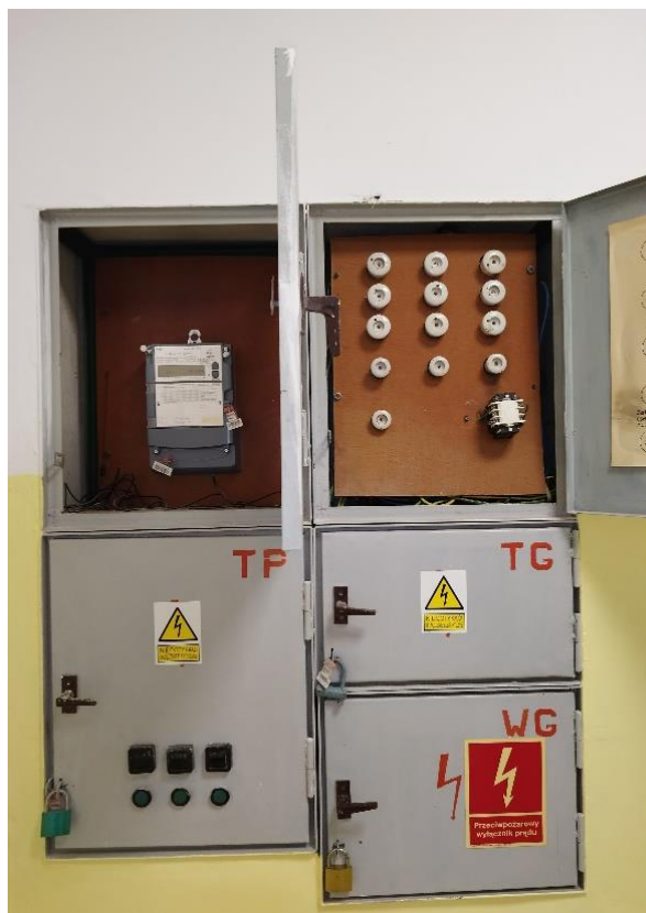
Figura 7 Licznik oraz zabezpieczenia 63A
